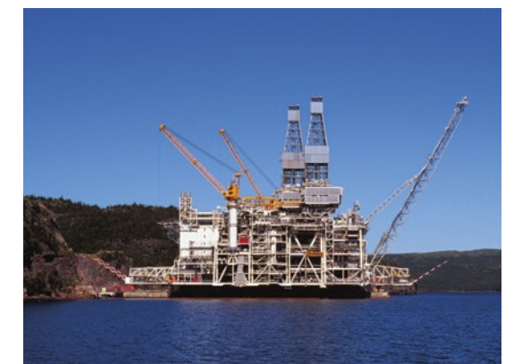
Plataforma marítima Hibernia, situada frente a las costas de Terranova.
